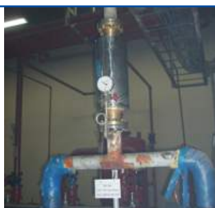
Después de la instalación
