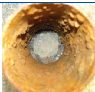
Primera inspección (January 29, 2008)
