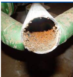
Antes de la Instalación
