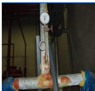
Antes de la instalación
