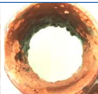
Tercera inspección (Mayo 6, 2009)
