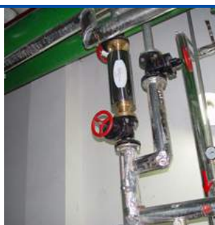
Después de la instalación
